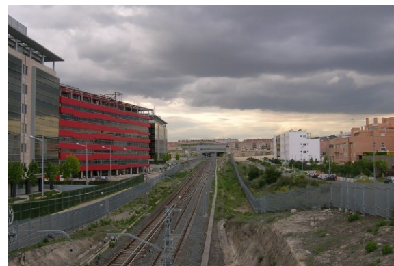
Sentido estación de Rivas Futura
