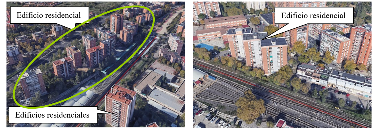
Vista aérea. Detalle de edificio próximo a la vía (ref. Google Earth)
