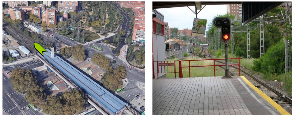
Estación de Aluche (ref. Google Earth y visita de campo )
