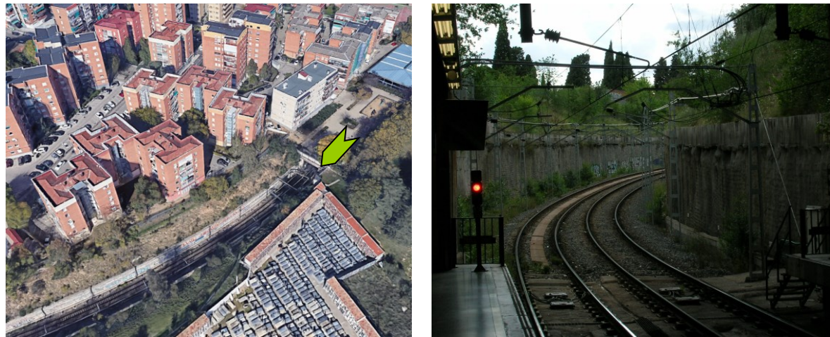
Proximidades de la estación de Eugenia de Montijo (ref. Google Earth y visita de campo )
