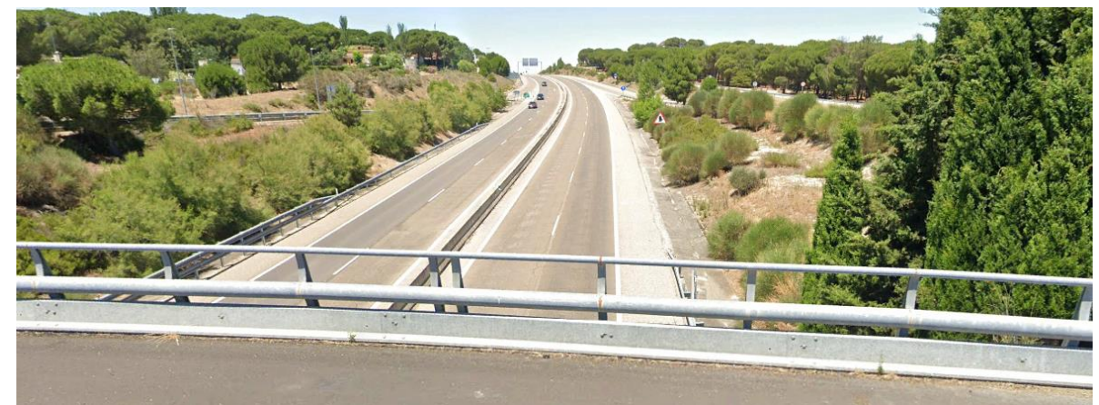
Inicio y Final tramo 2 (ref. Google Earth)
