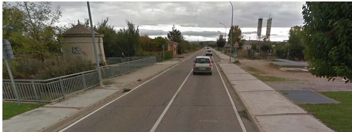
Inicio y Final tramo 2 (ref. Google Earth)
