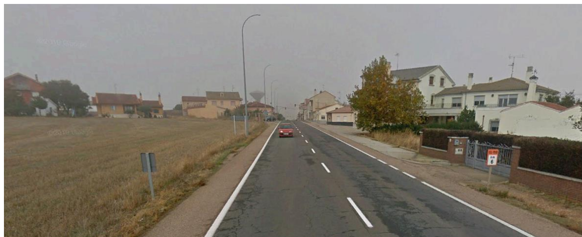
Inicio y Final tramo 2 (ref. visita de campo )
