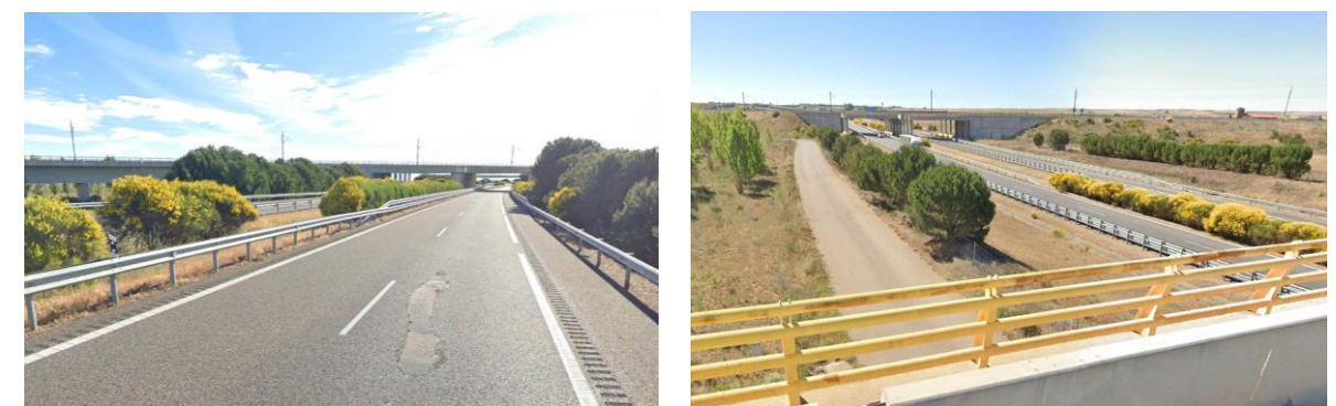
Puentes línea AVE (ref. Google Earth)
