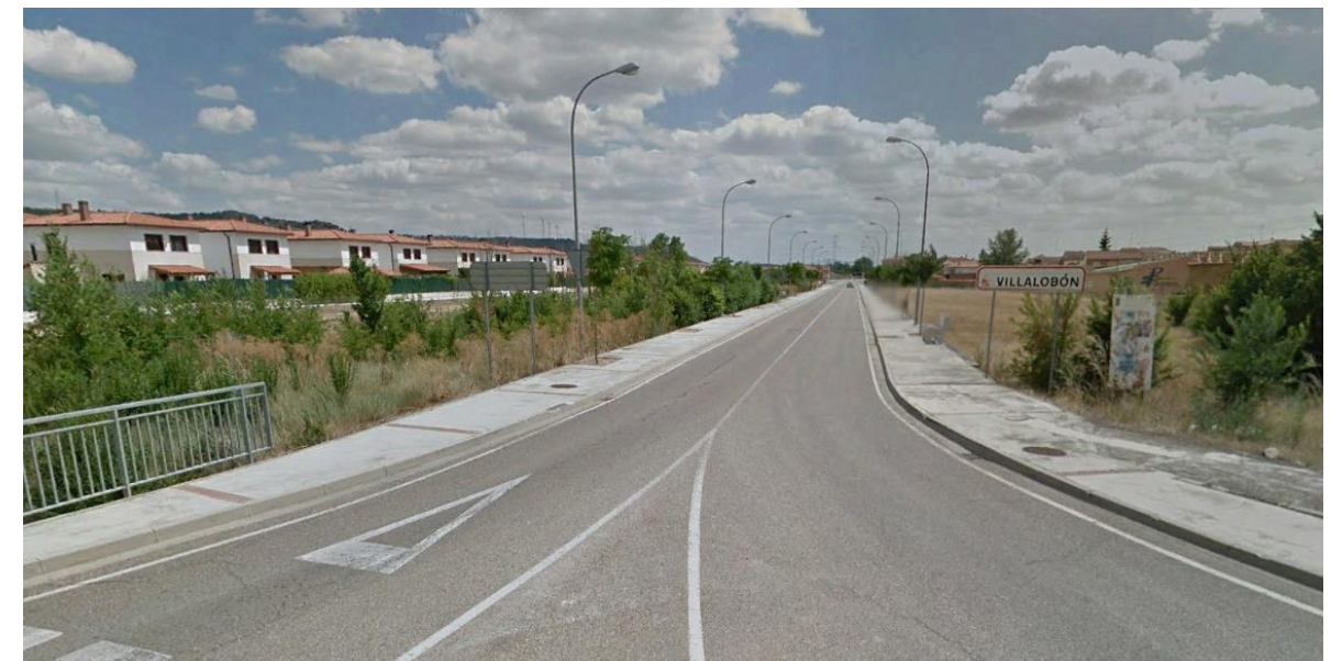
Inicio y Final tramo 3 (ref. Google Earth)
