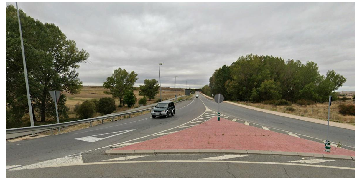
Inicio y Final tramo 1 (ref. Google Earth)
