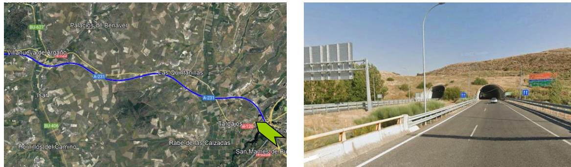
Vista del túnel presente en el tramo (ref. Google Earth)
