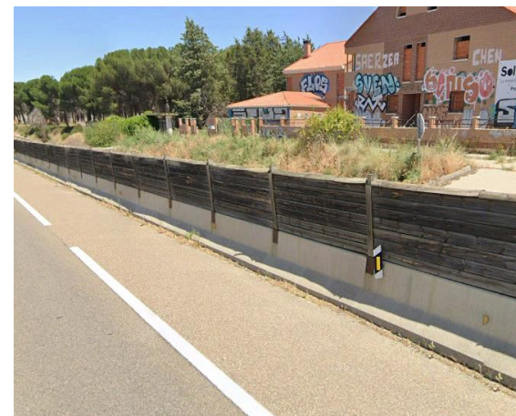
Pantallas acústicas en el trazado (ref. Google Earth)
