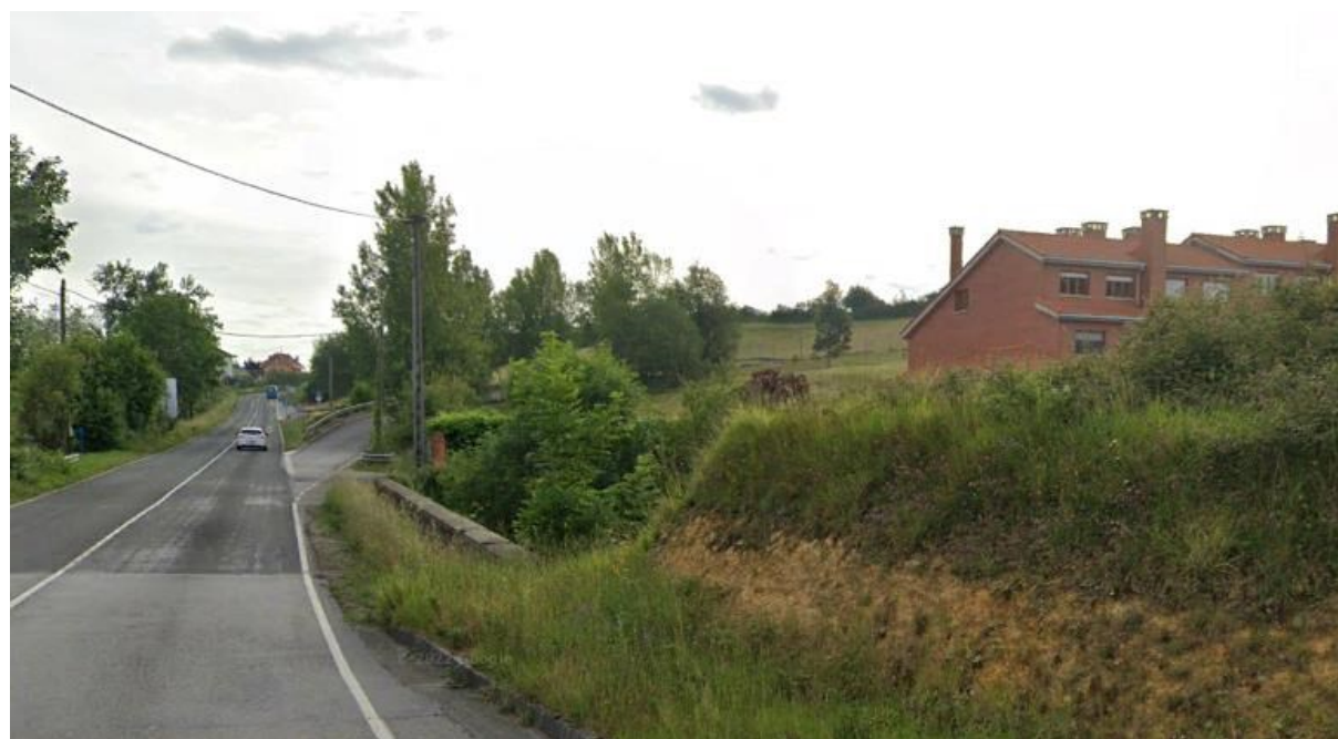
Figura 6. Imagen de la UME a su paso por La Fresneda (paso superior sobre ferrocarril)
