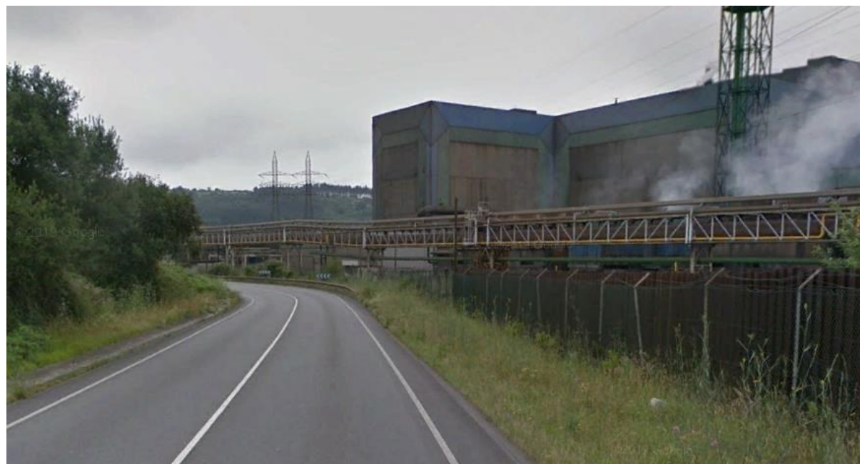
Figura 1. Vista de la AS-110 atravesando una zona industrial
