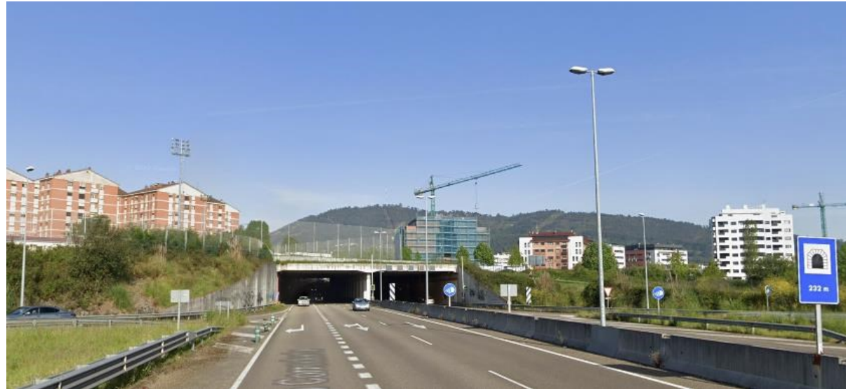
Figura 9. Imagen de la entrada al túnel de la UME AS-392
