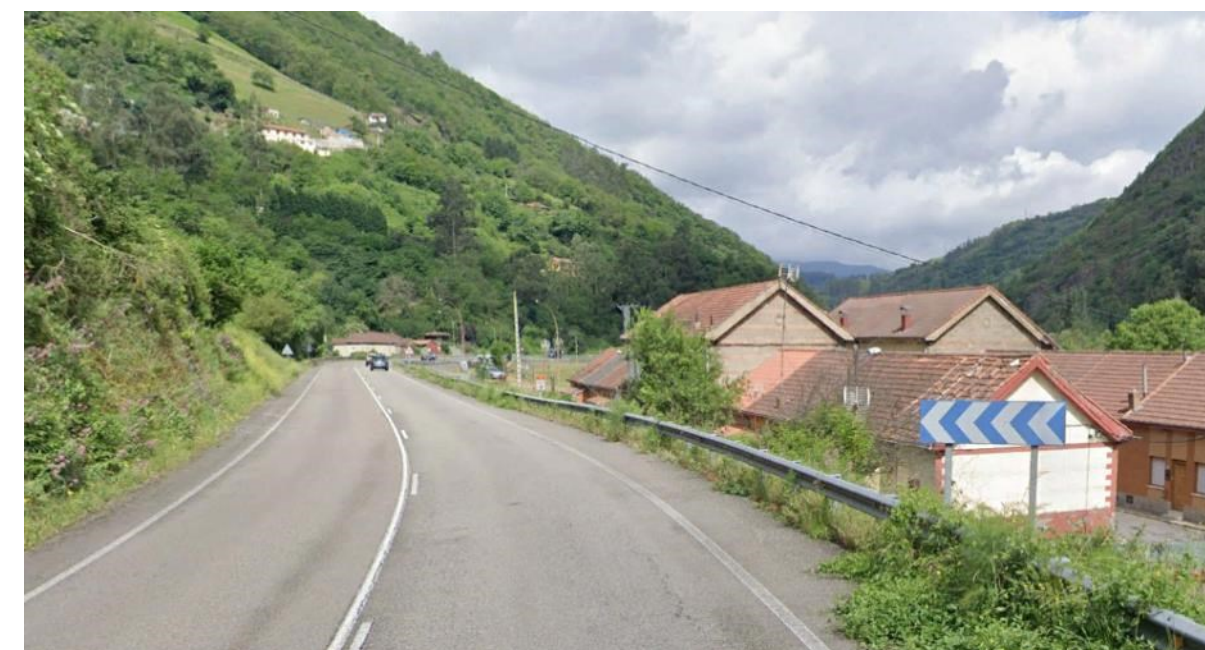
Figura 2. Vista de la AS-112 a su paso por Bustiello
