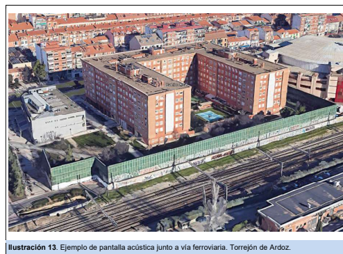
Ilustración 13. Ejemplo de pantalla acústica junto a vía ferroviaria. Torrejón de Ardoz.
