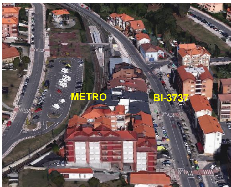
Foto de detalle de zona con el paso de las vías del METRO BILBAO y la BI-3737.
