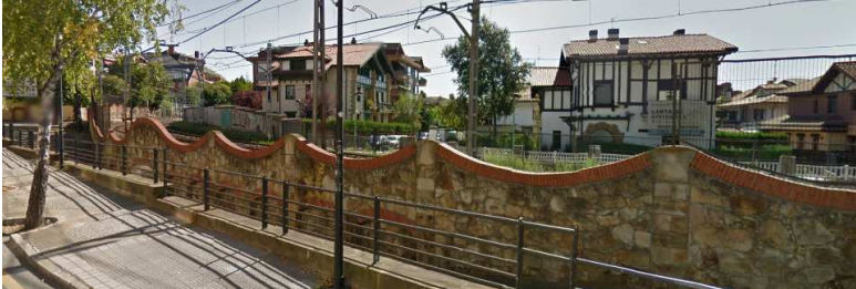
Muro de la zona de la curva
