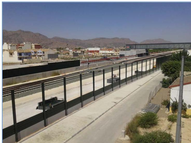
Figura 4: Ejemplos de pantallas acústica para ruido ferroviario
