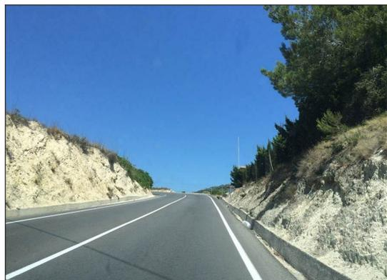
**Ilustración 12:** Desmontes en ambos márgenes en la CV-737
