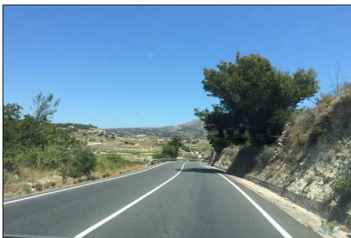
**Ilustración 37: Desmonte en el margen derecho de la CV-743-2**
