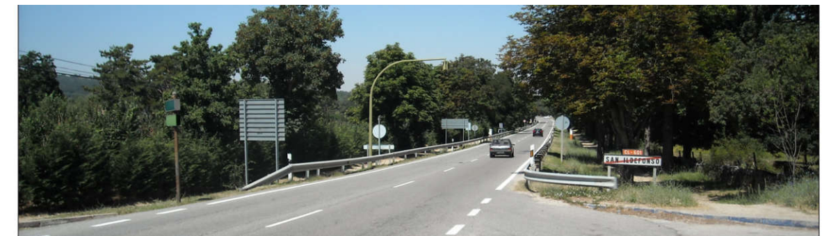
Inicio y Final del tramo 3 (ref. visita de campo )
