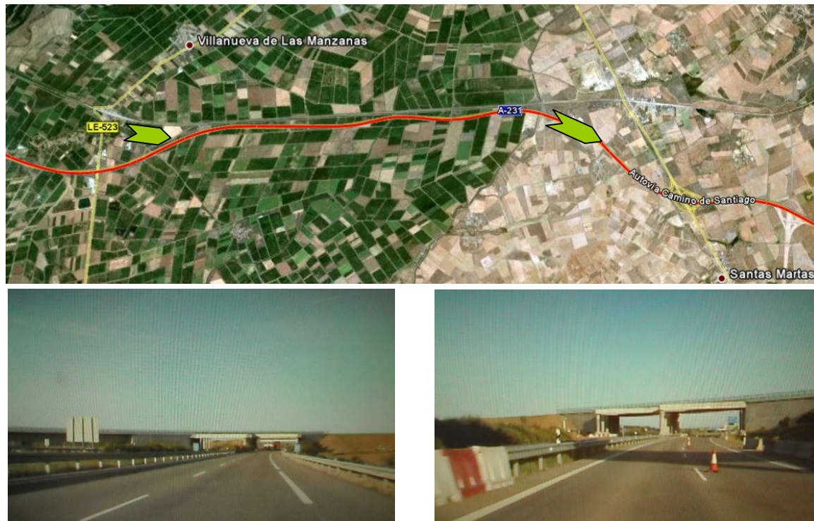
Puentes futura línea AVE (ortofoto y visita de campo )
