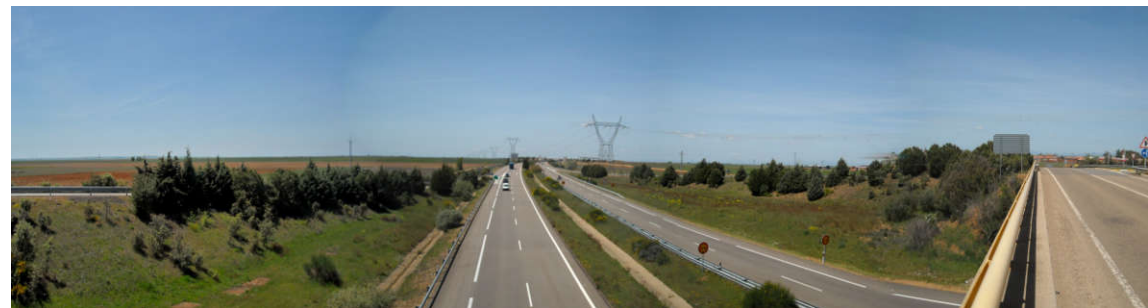
Inicio y Final del tramo 3 (ref. visita de campo )
