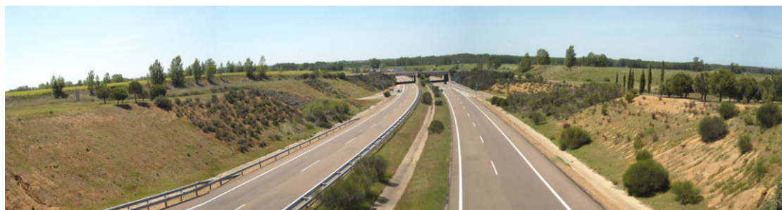
Inicio y Final del tramo 4 (ortofoto y visita de campo )
