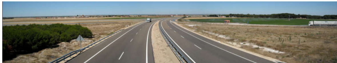
Inicio y Final del tramo 3 (ref. visita de campo )
