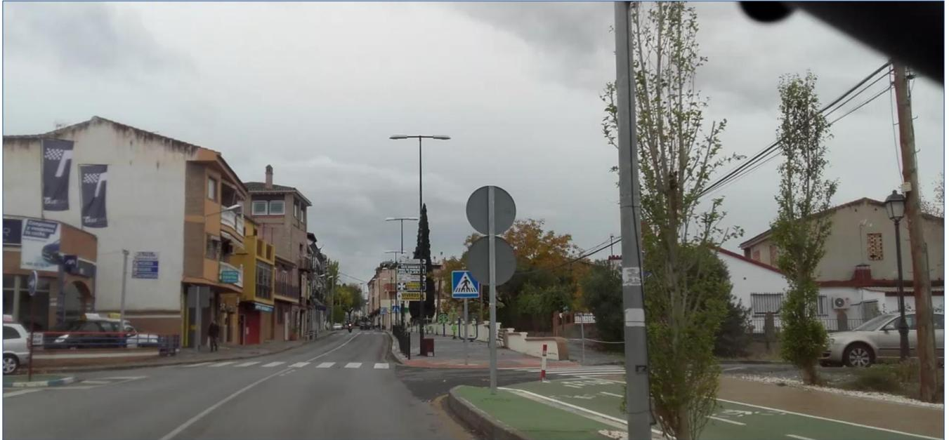
*Foto 1: sentido ascendente, vista del fin del carril bici paralelo a la carretera en Ogíjares. Vía de doble sentido y un carril por sentido. Velocidad limitada a 50 Km/h. Edificaciones de tipo residencial a ambos márgenes.*
