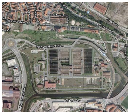
Imagen: paso del metro en superficie en el entorno de la Estación de Urbinaga (en superficie)
