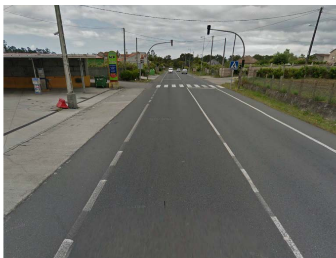
Figura 3. PO-307 zona a Pantrigueira
