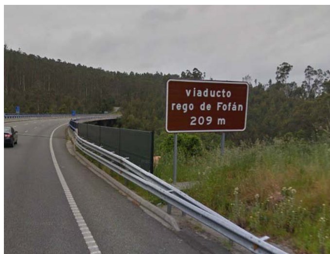
Figura 5. Viaducto Rego de Fofán. Pantallas acústicas
