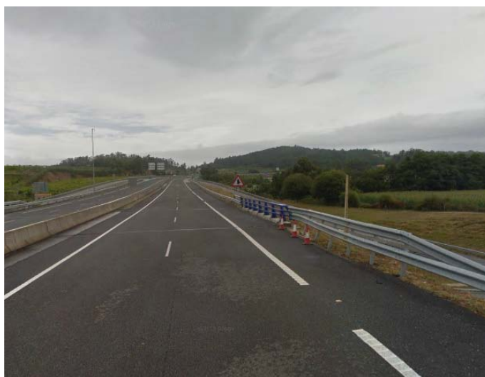
Figura 3. Viaducto sobre enlace San Martiño de Meis-VG-4.2
