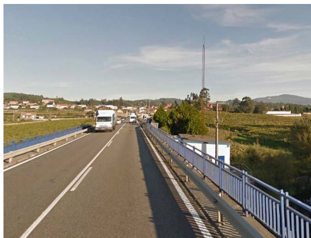
Figura 6. PO-531. Viaducto sobre el río Umia. Núcleo de A Lagoa al fondo
