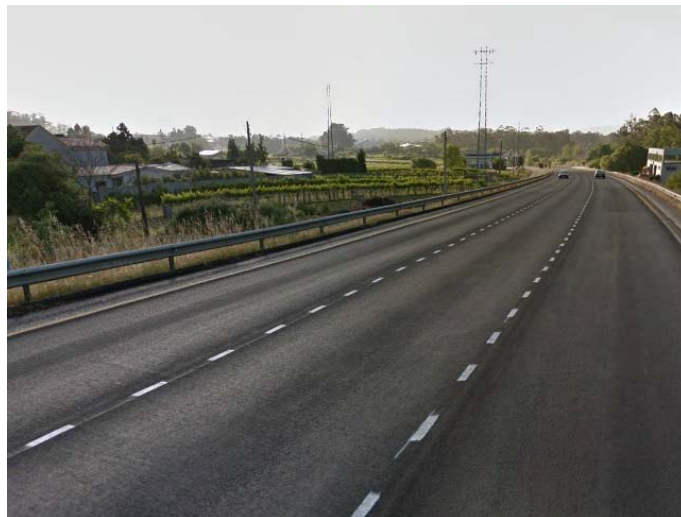
Figura 5. PO-510 a su paso por Montecelo
