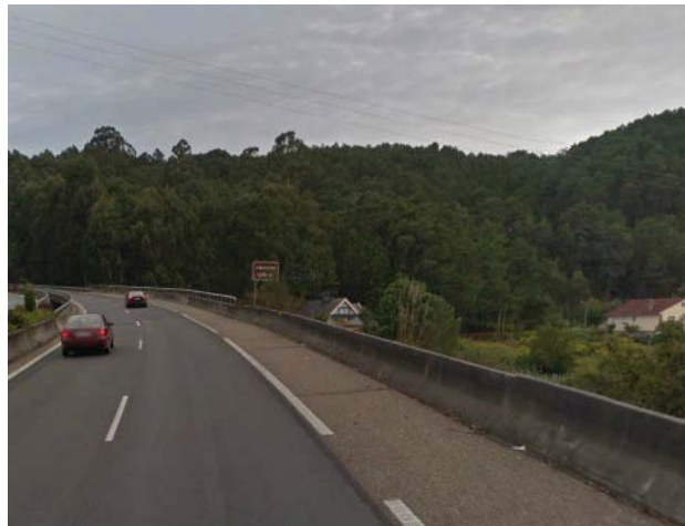
Figura 2. AG-57 Viaducto de Villaza. Gondomar
