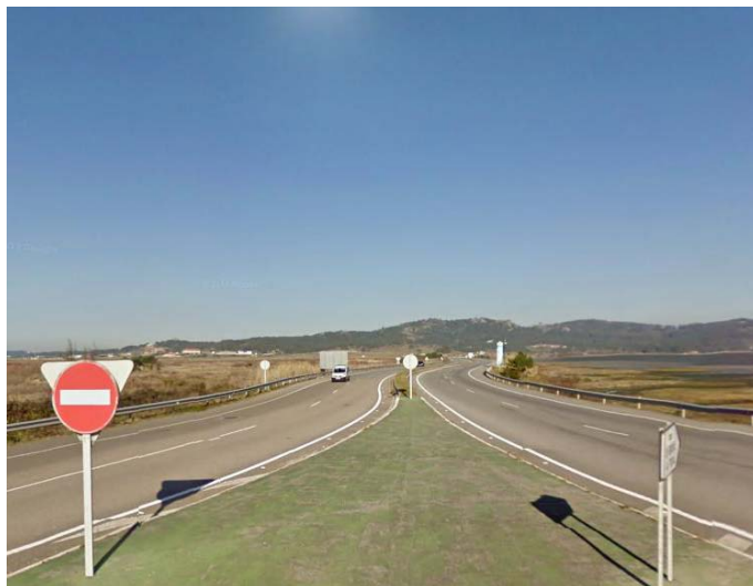
Figura 2. PO-316. Inicio pk0+000
