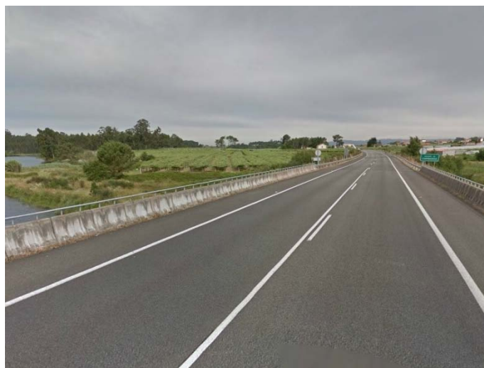
Figura 3. VG-4.2. Viaducto sobre el Río Umia.
