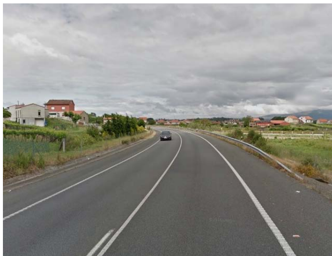
Figura 3. PO-530. Parte final de tramo de estudio. A la altura de Cardalda
