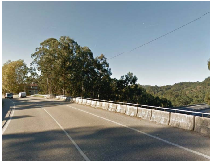
Figura 2. PO-331. Viaducto sobre la AG-57
