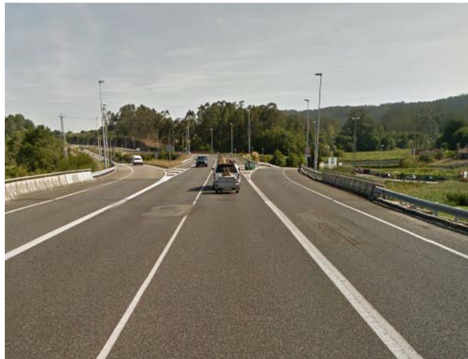
Figura 1. VG-4.1. Viaducto sobre O Vinquiño
