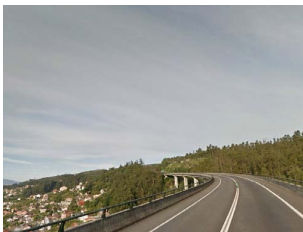
Figura 3. CG-4.1. Viaducto de Moura. Verdeal
