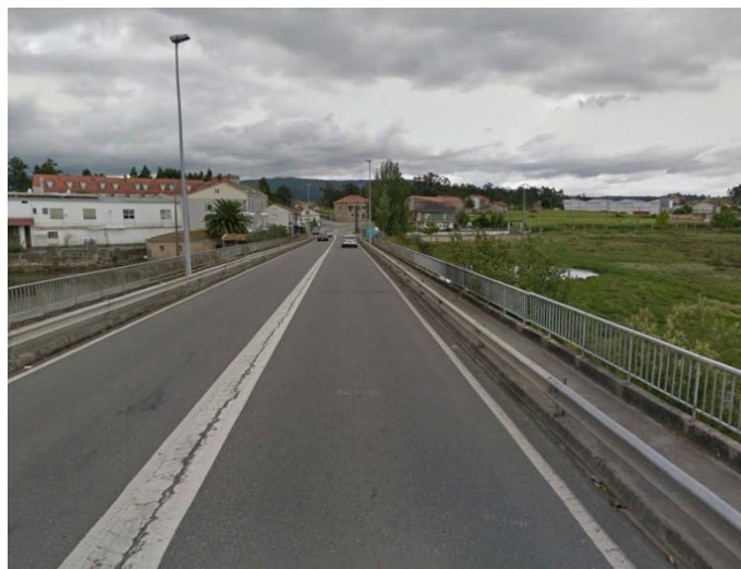
Figura 4. PO-550. Viaducto del Umia
