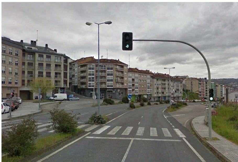
Vista general de la sección tipo del tramo de salida de Ourense con mediana de separación entre calzadas. En este tramo, además, existe regulación semafórica.
