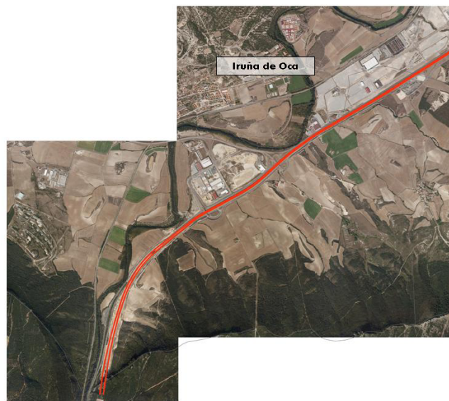
Figura nº 3. UME 1 – Carretera N-I. Tramo 2 Iruña de Oca
