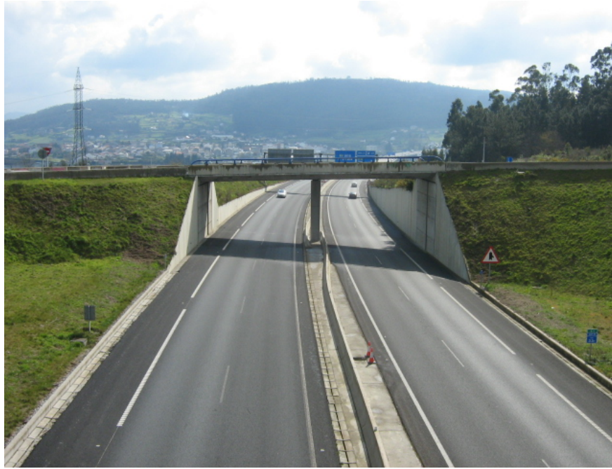
Vista de la AP-9 desde el Paso Superior del P.K 33+240F
