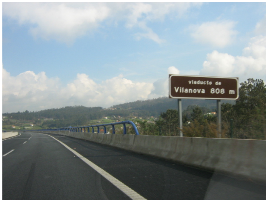
Viaducto de Vilanova
