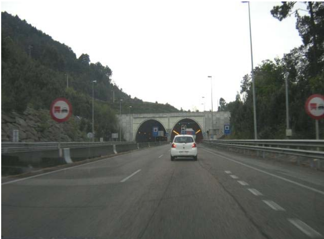
Túnel de A Madroa
